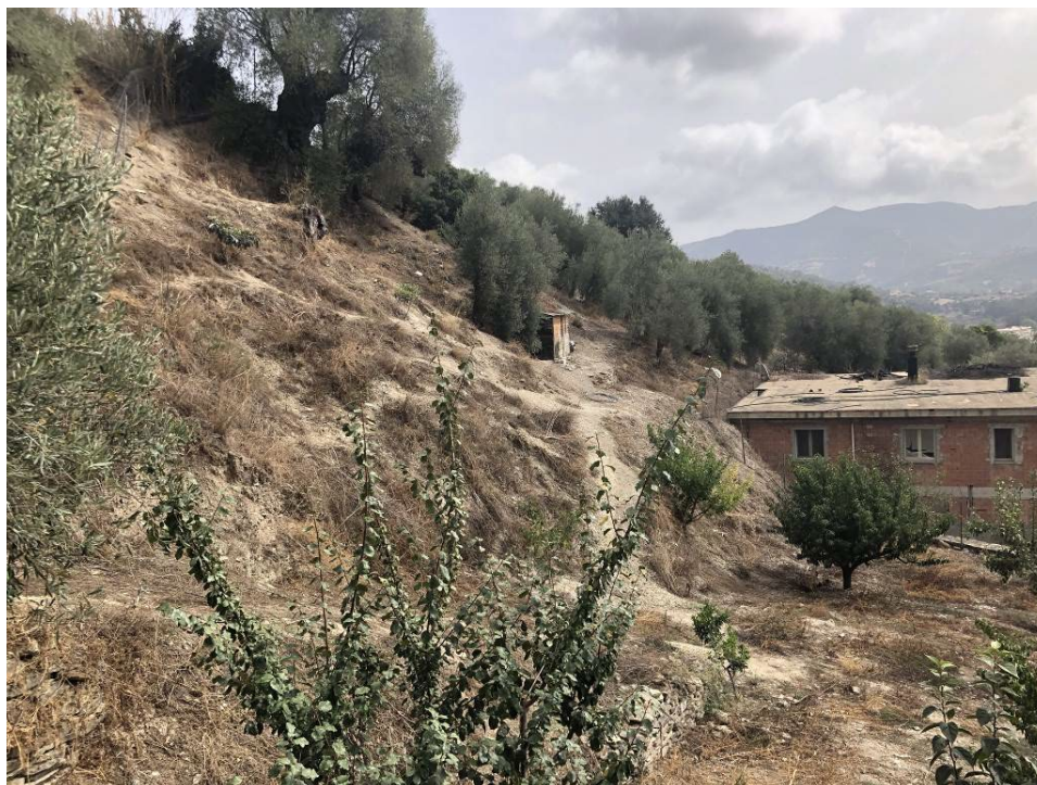
Figura 7 – Sedimenti detritici sciolti in sponda sinistra del Funtana Manna, dove verranno realizzate palificate semplici per la trattenuta del materiale.
