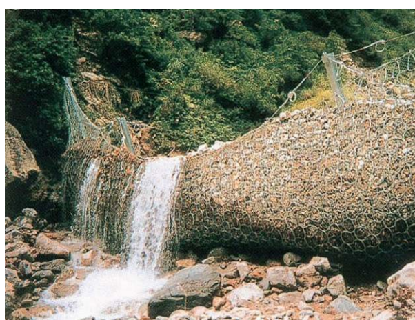
Figura 16 – Esempio di barriera debris flow in fase di realizzazione ed esempio di barriera interessata da evento.
